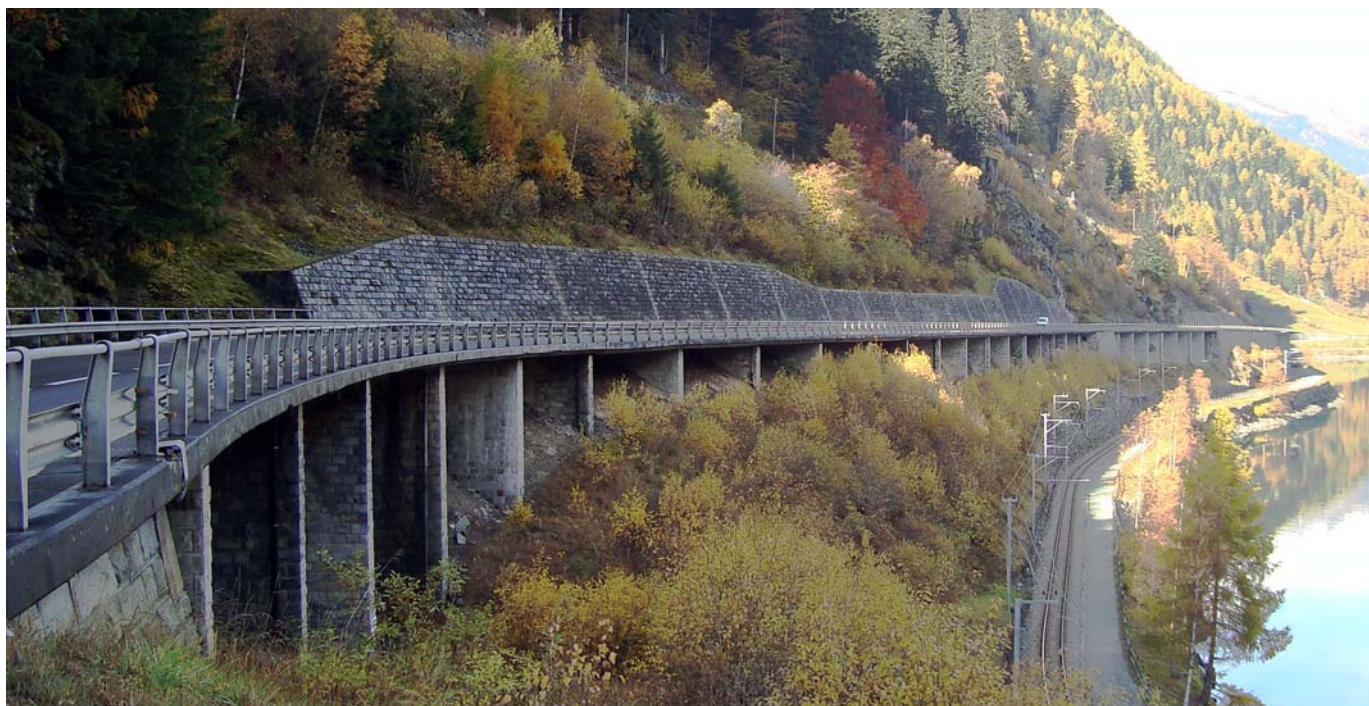
Tra il 2014 e il 2017 dovranno essere sistemati sei ponti per una lunghezza complessiva di 600 metri.
